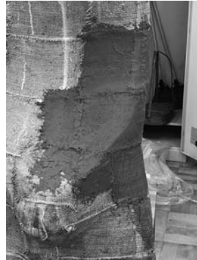
【写真 11】 コンクリートボンドの塗り込み
