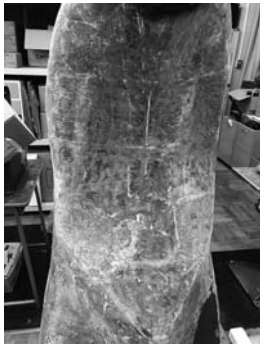
【写真 12】 コンクリートボンドの ヤスリがけ
